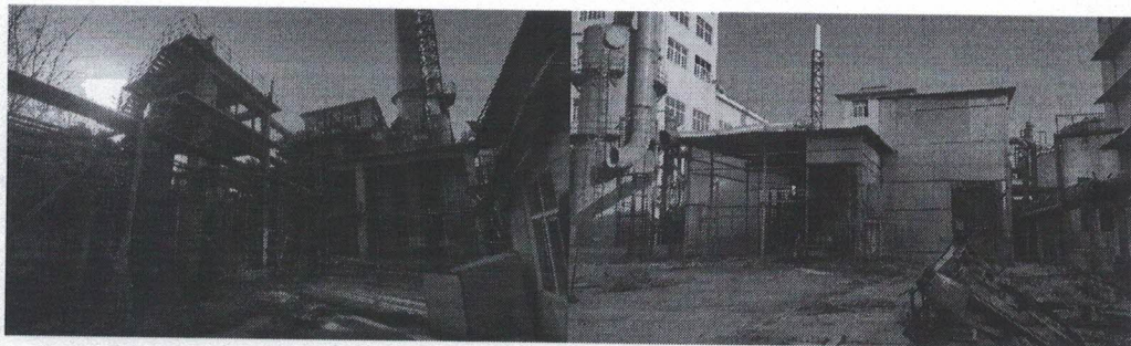
13、氢钾车间：拆除全部设备和厂房、地下基础、设备地坑。 (从原料到盐酸罐区。) 保留南侧的散装库。
